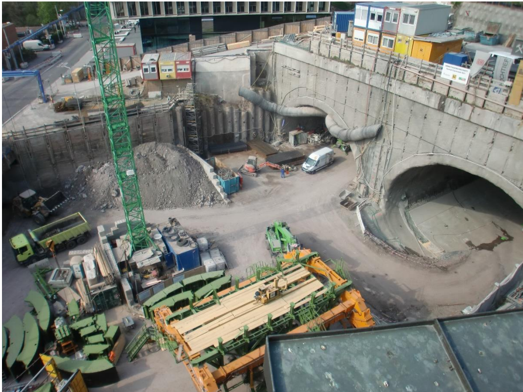
Abbildung 2: Blick auf das Baufeld bei Messende am 03.04.2017
