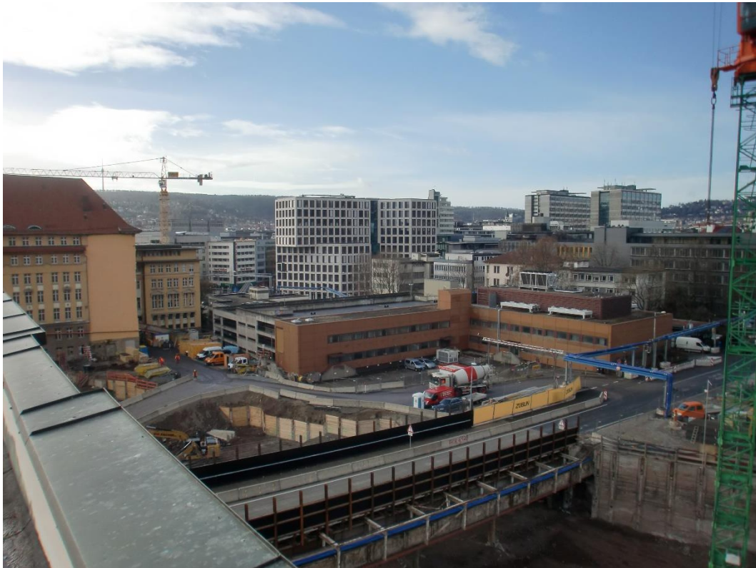
Abbildung 2: Blick auf das Baufeld bei Messende am 06.03.2017
