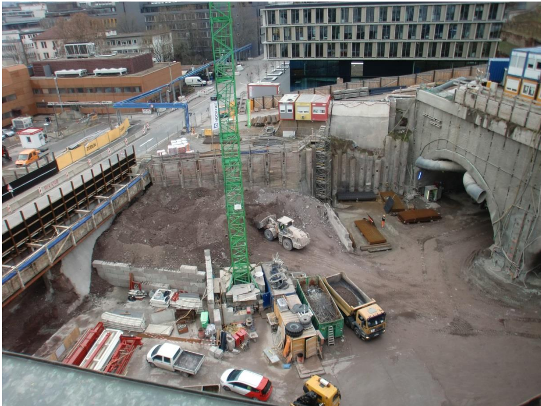
Abbildung 2: Blick auf das Baufeld bei Messende am 06.02.2017
