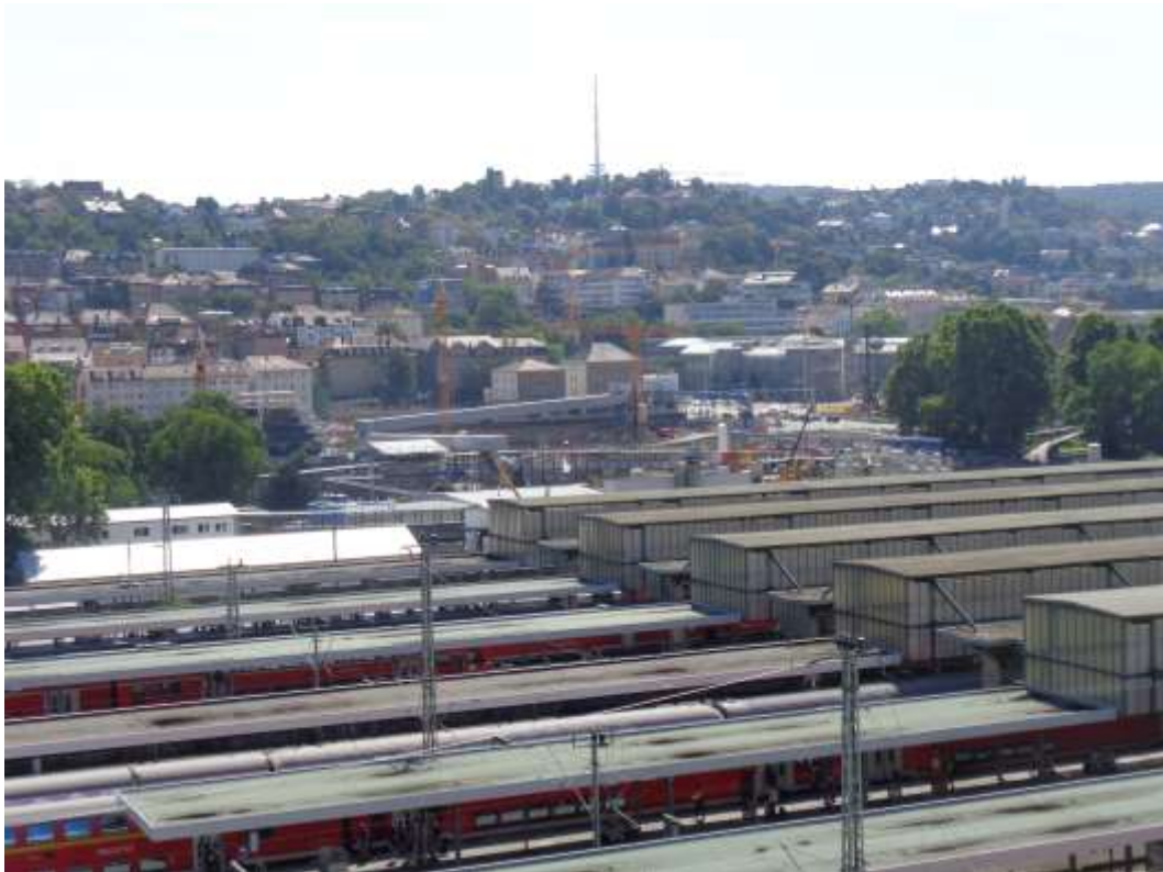
Abbildung 2: Blick auf das Baufeld bei Messende am 15.08.2016
