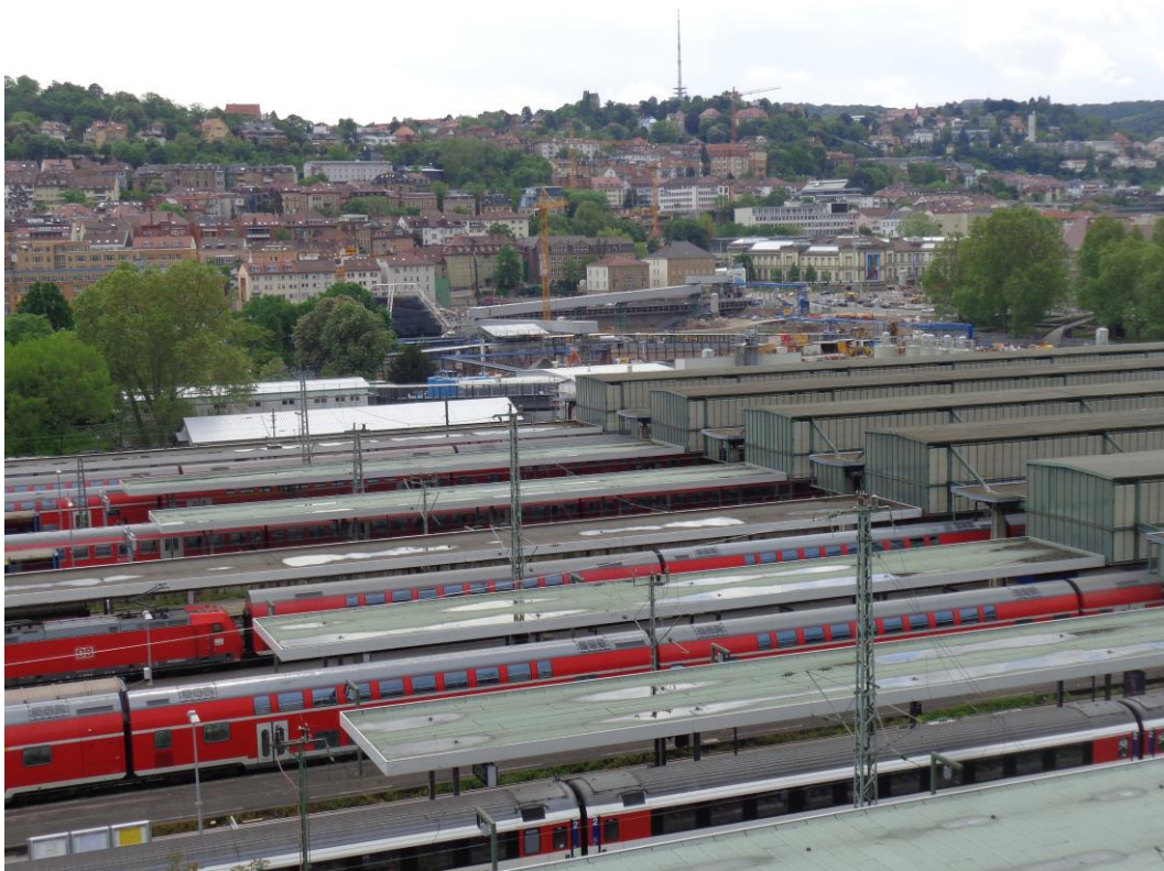
Abbildung 2: Blick auf das Baufeld bei Messende am 17.05.2016
