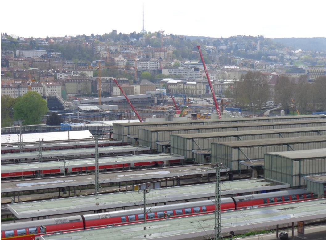
Abbildung 2: Blick auf das Baufeld bei Messende am 18.04.2016
