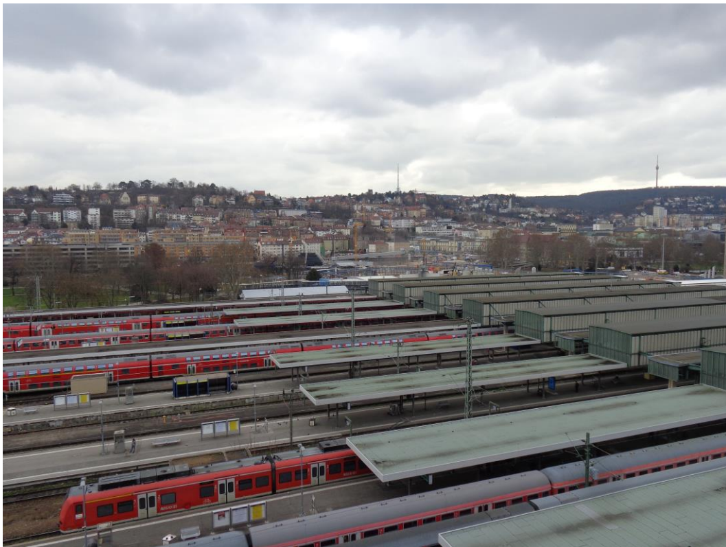
Abbildung 2: Blick auf das Baufeld bei Messende am 21.03.2016
