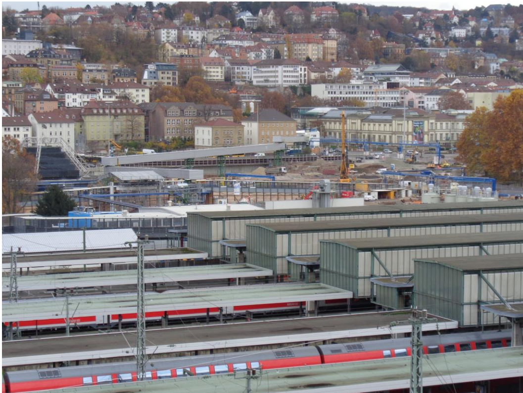
Abbildung 2: Blick auf das Baufeld bei Messende am 09.11.2015
