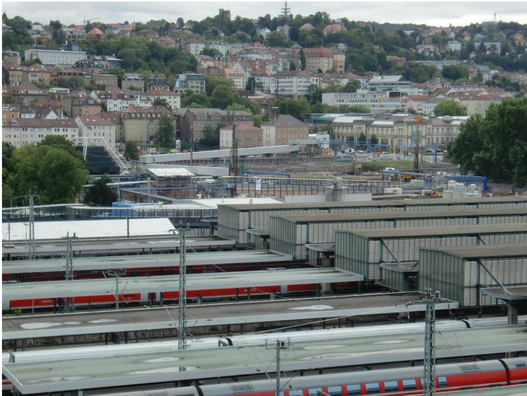
Abbildung 2: Blick auf das Baufeld bei Messende am 07.09.2015
