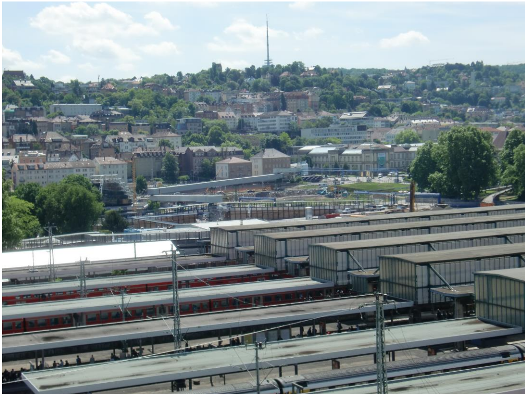
Abbildung 2: Blick auf das Baufeld bei Messende am 18.05.2015
