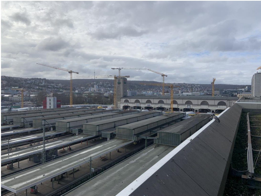
Abbildung 2: Blick auf das Baufeld bei Messende am 27.03.2023
