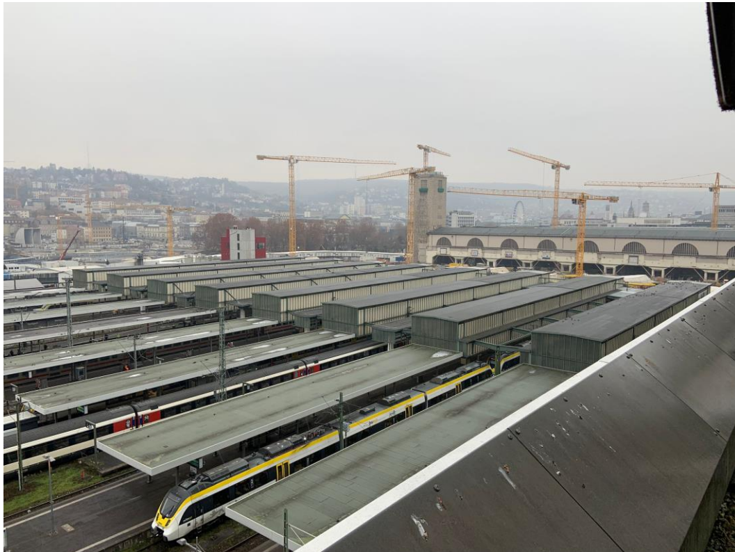
Abbildung 2: Blick auf das Baufeld bei Messende am 19.12.2022
