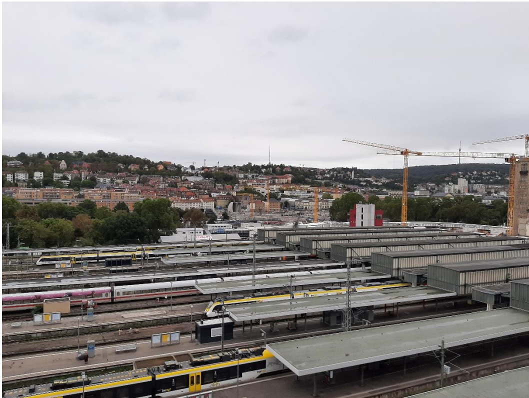
Abbildung 2: Blick auf das Baufeld bei Messende am 19.09.2022
