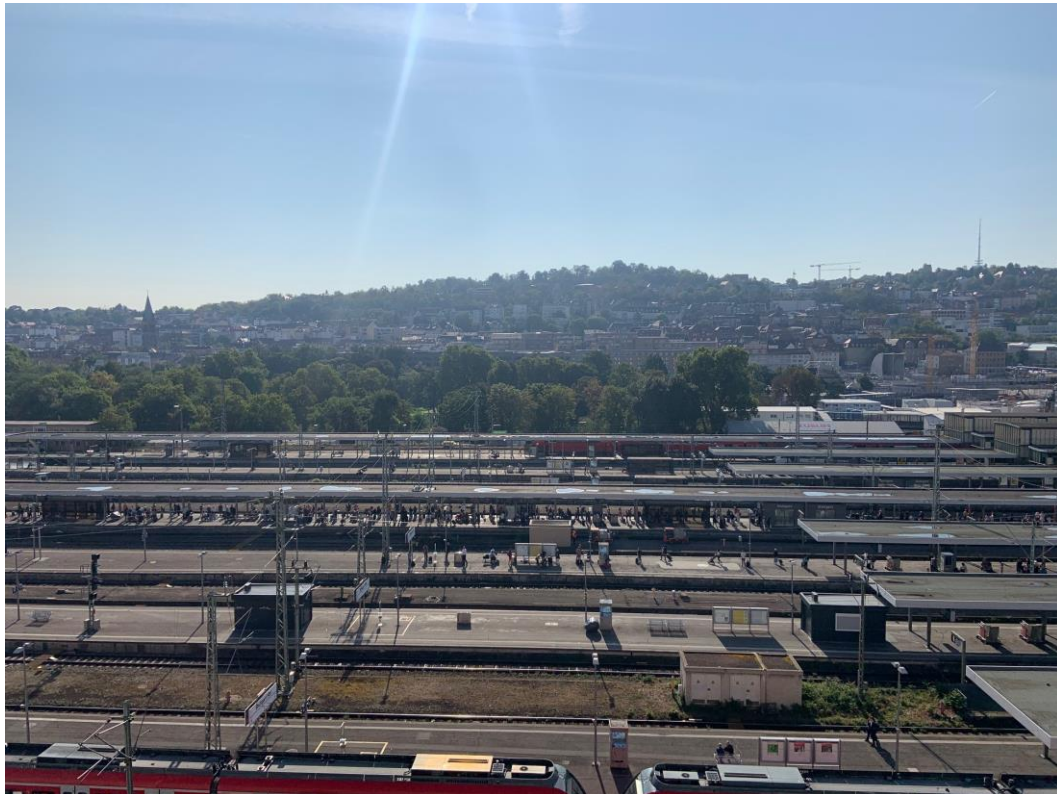
Abbildung 2: Blick auf das Baufeld bei Messende am 29.08.2022
