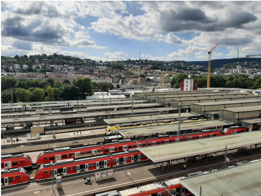
Abbildung 2: Blick auf das Baufeld bei Messende am 01.08.2022
