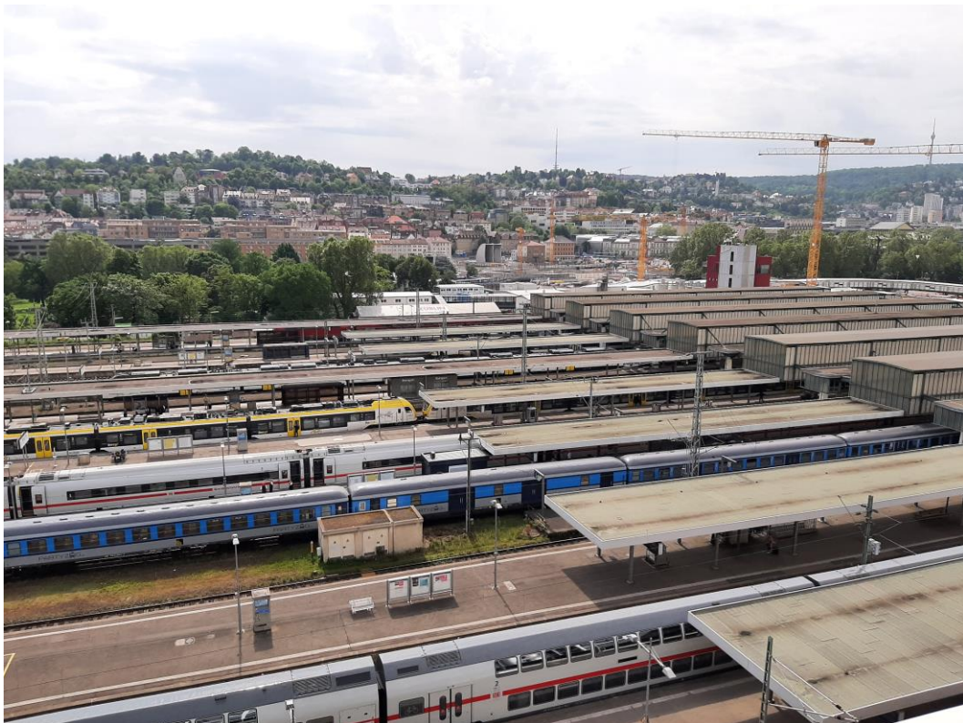
Abbildung 2: Blick auf das Baufeld bei Messende am 16.05.2022
