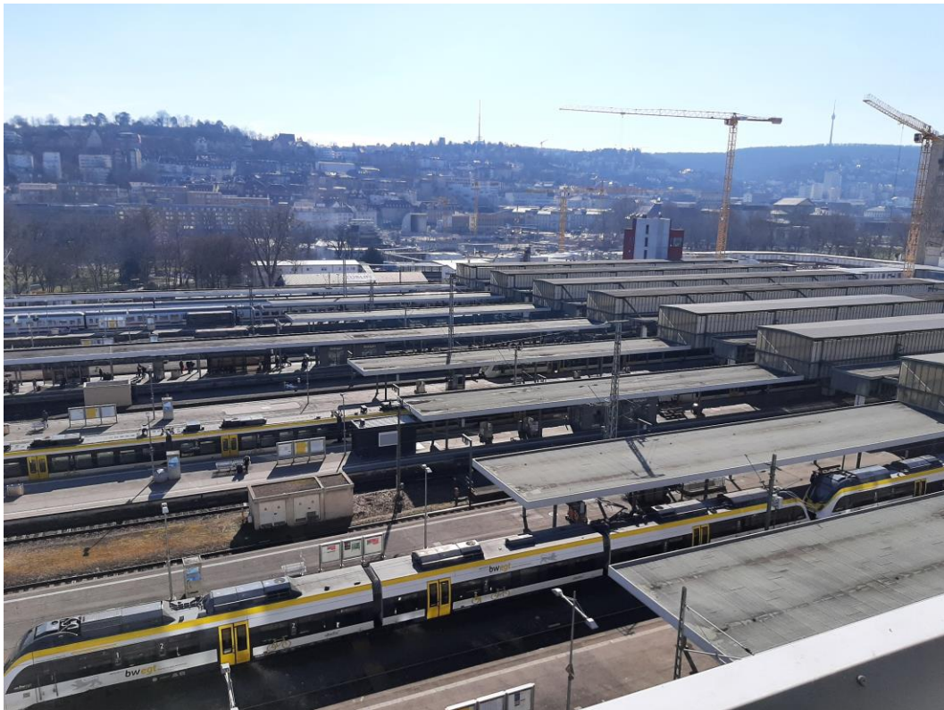
Abbildung 2: Blick auf das Baufeld bei Messende am 07.03.2022
