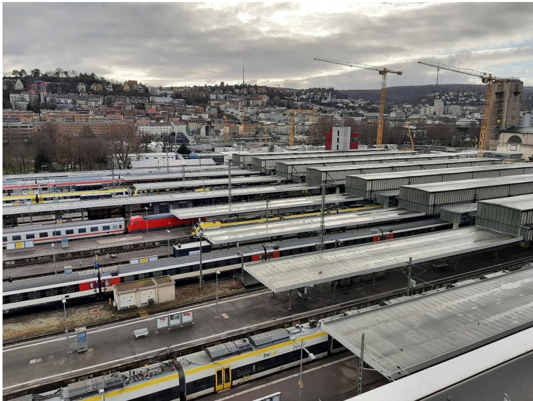
Abbildung 2: Blick auf das Baufeld bei Messende am 07.02.2022
