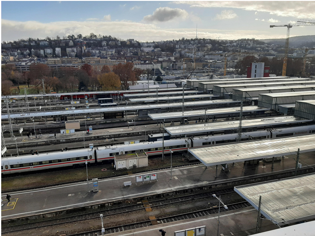
Abbildung 2: Blick auf das Baufeld bei Messende am 29.11.2021
