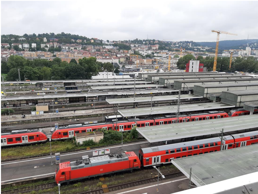
Abbildung 2: Blick auf das Baufeld bei Messende am 30.08.2021
