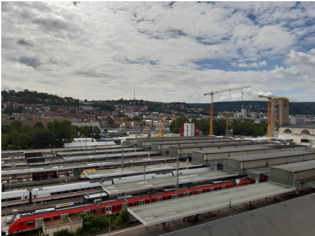
Abbildung 2: Blick auf das Baufeld bei Messende am 02.08.2021
