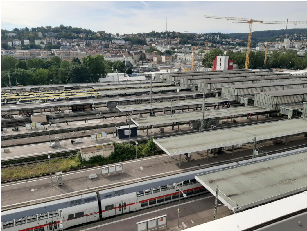
Abbildung 2: Blick auf das Baufeld bei Messende am 12.07.2021
