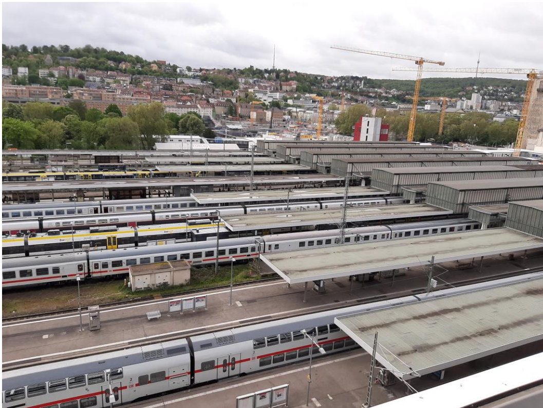
Abbildung 2: Blick auf das Baufeld bei Messende am 17.05.2021
