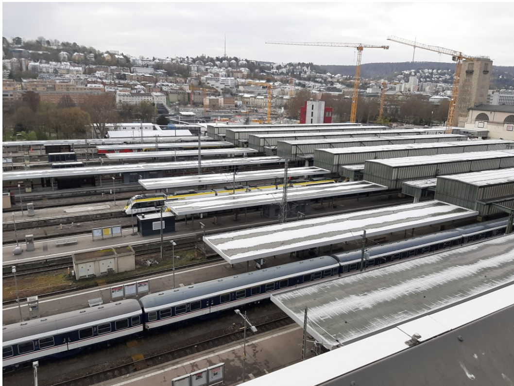
Abbildung 2: Blick auf das Baufeld bei Messende am 05.04.2021
