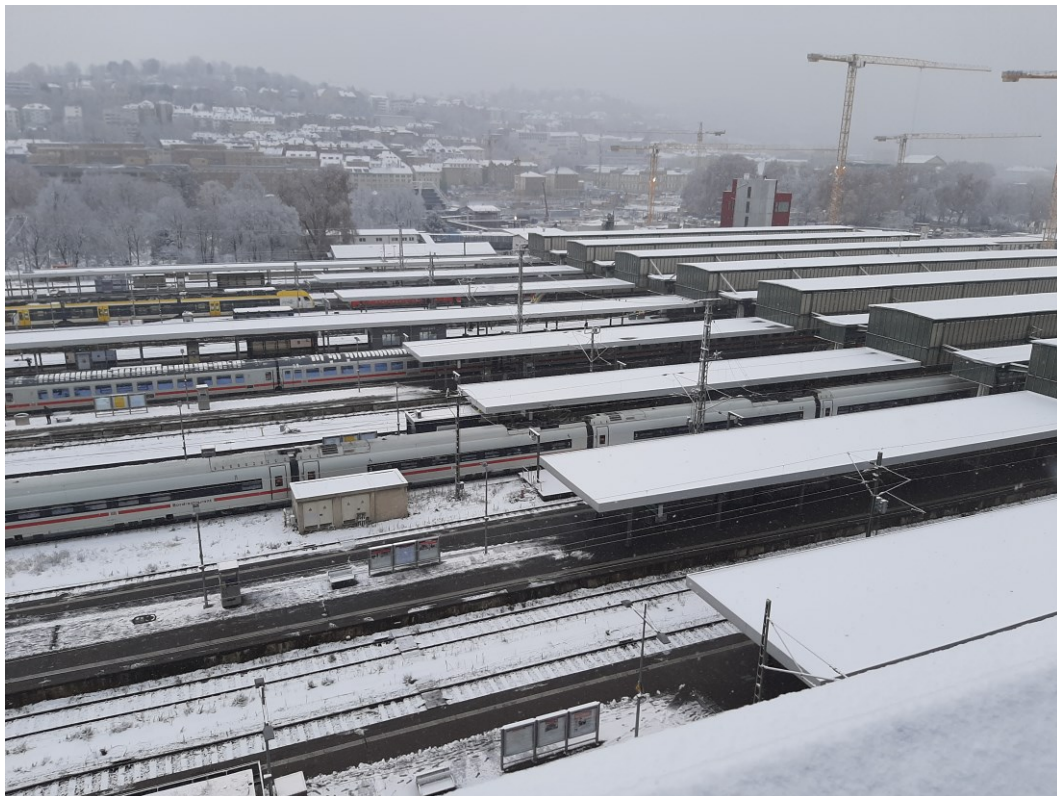
Abbildung 2: Blick auf das Baufeld bei Messende am 25.01.2021
