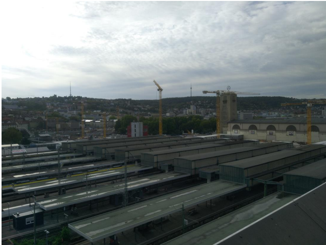
Abbildung 2: Blick auf das Baufeld bei Messende am 06.10.2020
