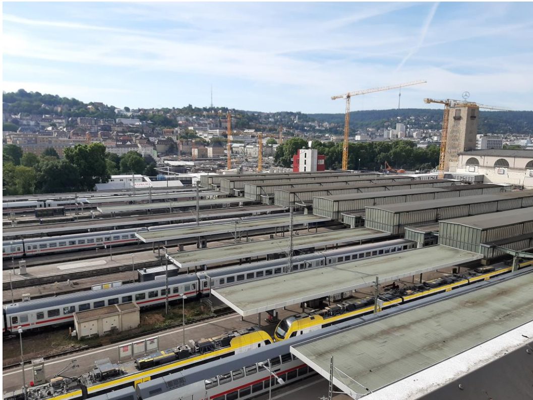
Abbildung 2: Blick auf das Baufeld bei Messende am 20.07.2020
