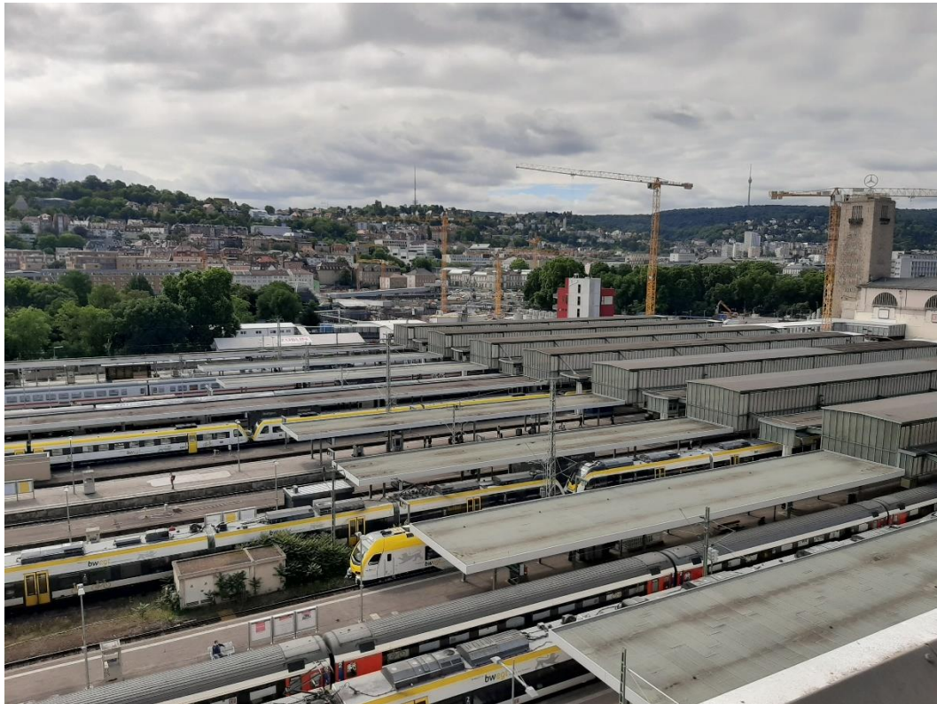
Abbildung 2: Blick auf das Baufeld bei Messende am 22.06.2020
