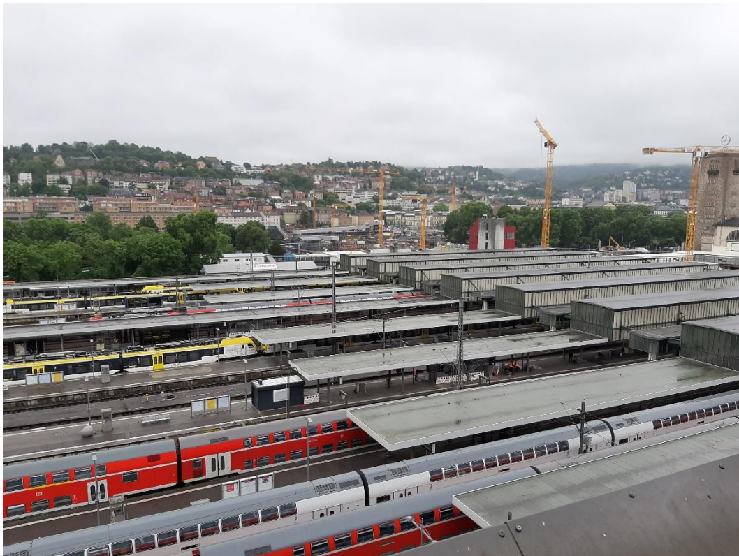
Abbildung 2: Blick auf das Baufeld bei Messende am 11.05.2020
