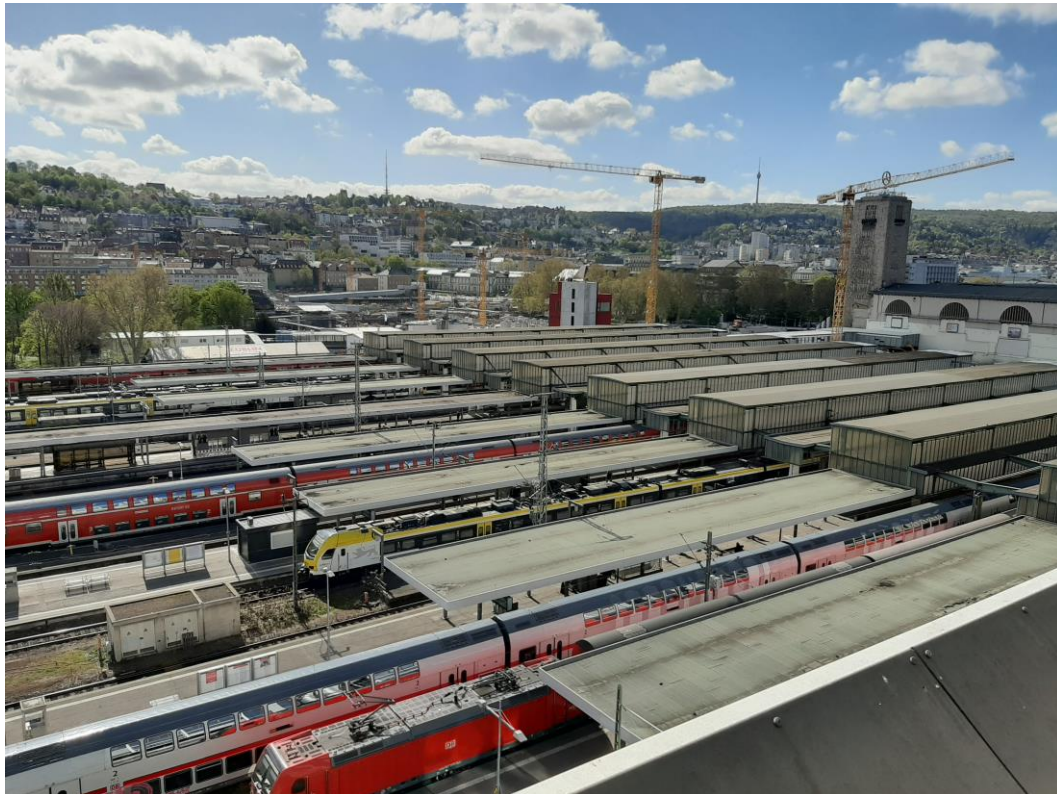
Abbildung 2: Blick auf das Baufeld bei Messende am 13.04.2020
