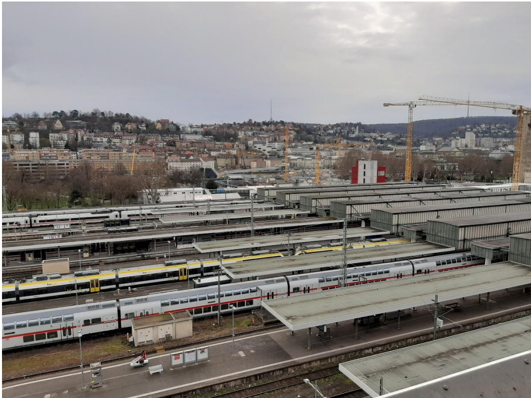
Abbildung 2: Blick auf das Baufeld bei Messende am 17.03.2020
