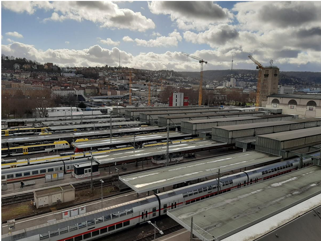
Abbildung 2: Blick auf das Baufeld bei Messende am 18.02.2020
