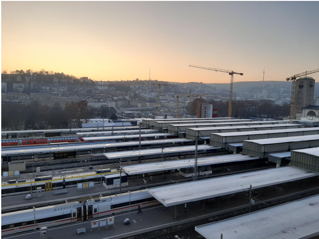
Abbildung 2: Blick auf das Baufeld bei Messende am 21.01.2020
