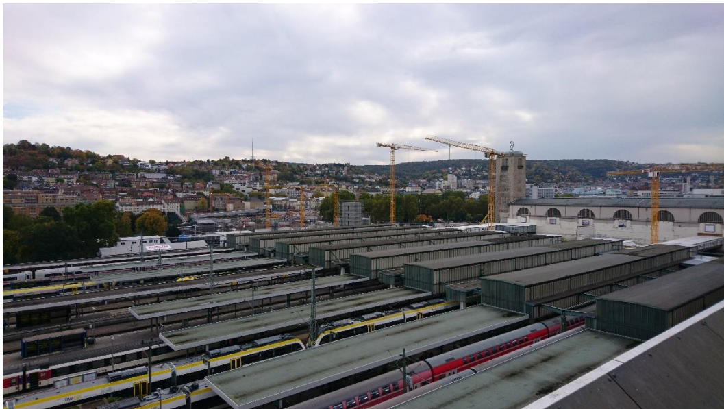
Abbildung 2: Blick auf das Baufeld bei Messende am 15.10.2019
