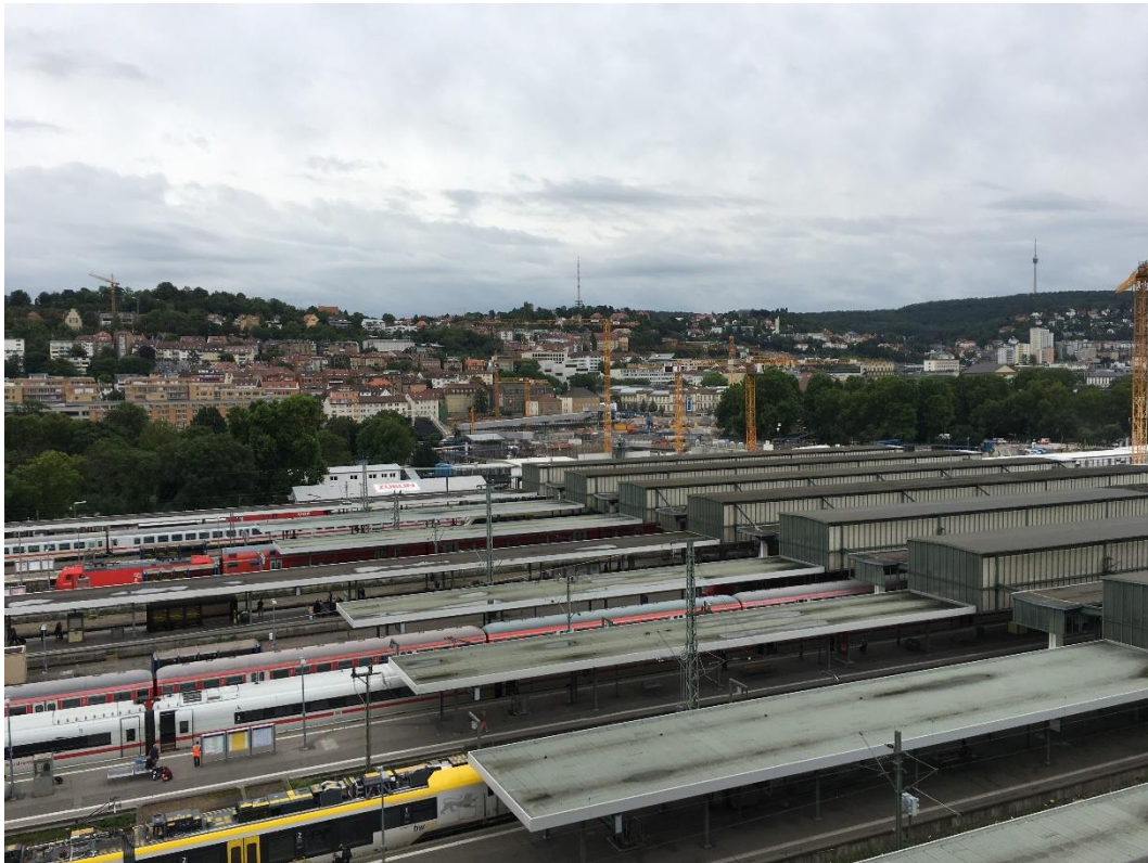
Abbildung 2: Blick auf das Baufeld bei Messende am 20.08.2019
