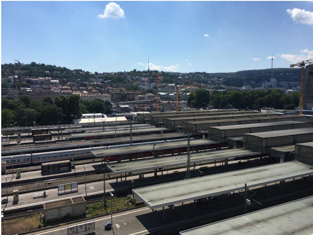
Abbildung 2: Blick auf das Baufeld bei Messende am 18.06.2019
