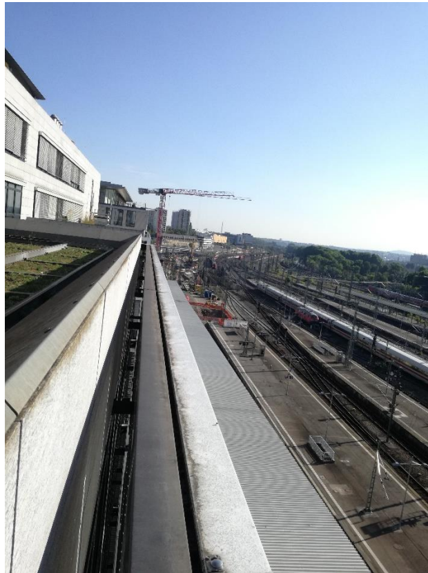
Abbildung 2: Blick auf das Baufeld bei Messende am 20.08.2018
