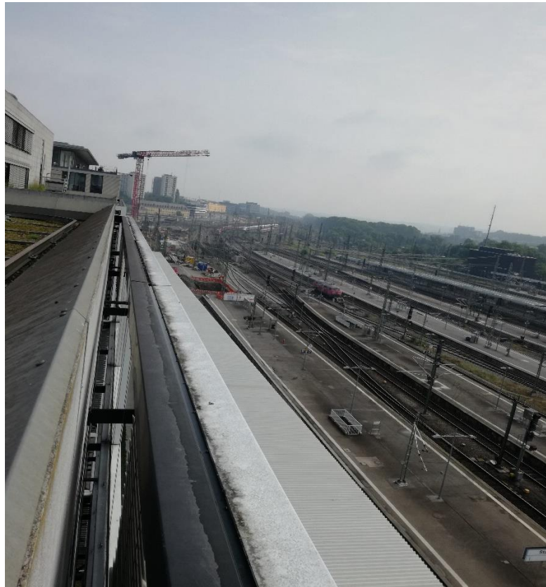
Abbildung 2: Blick auf das Baufeld bei Messende am 23.07.2018
