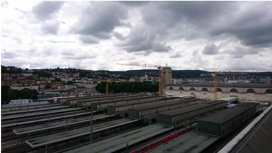
Abbildung 2: Blick auf das Baufeld bei Messende am 25.06.2018
