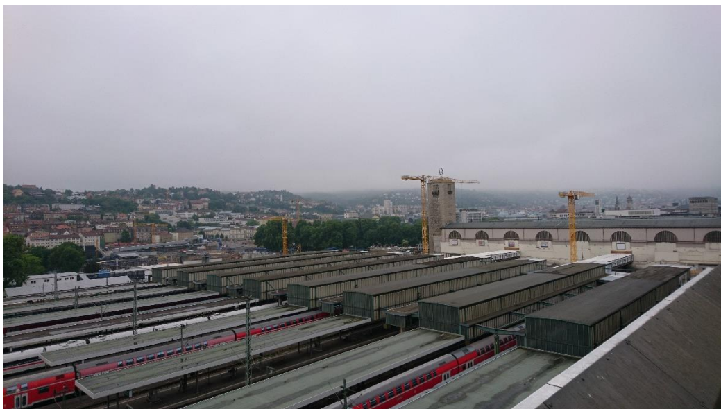
Abbildung 2: Blick auf das Baufeld bei Messende am 14.05.2018
