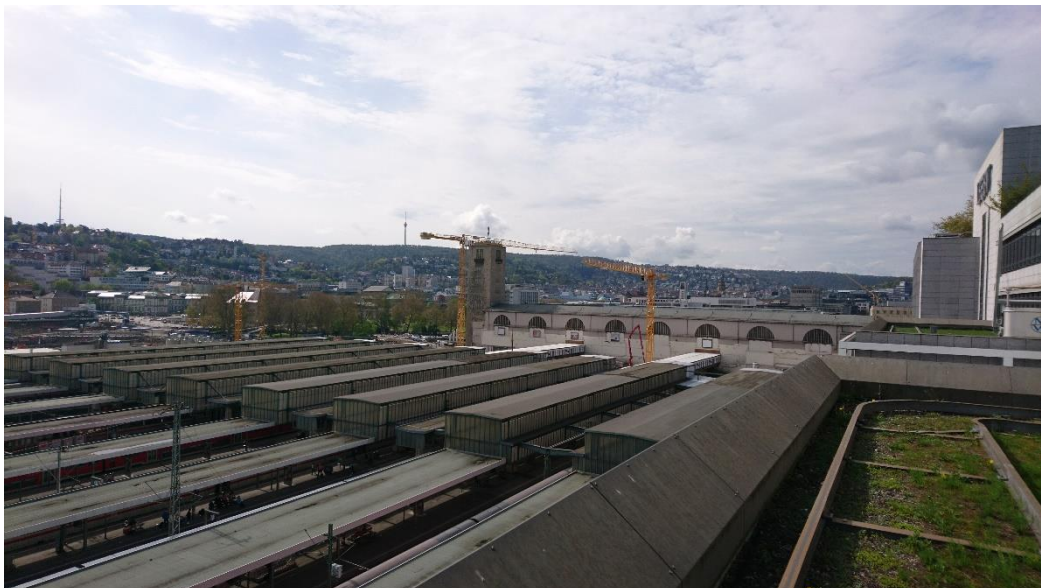
Abbildung 2: Blick auf das Baufeld bei Messende am 16.04.2018
