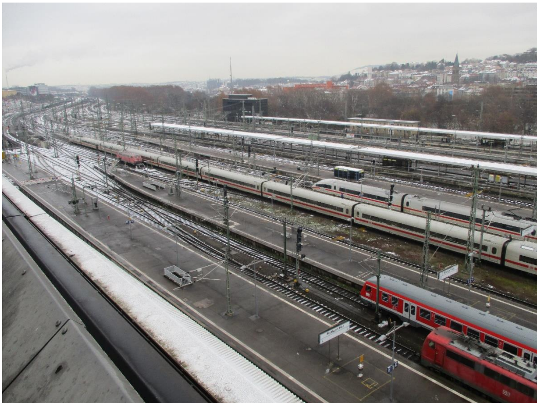
Abbildung 2: Blick auf das Baufeld bei Messende am 04.12.2017
