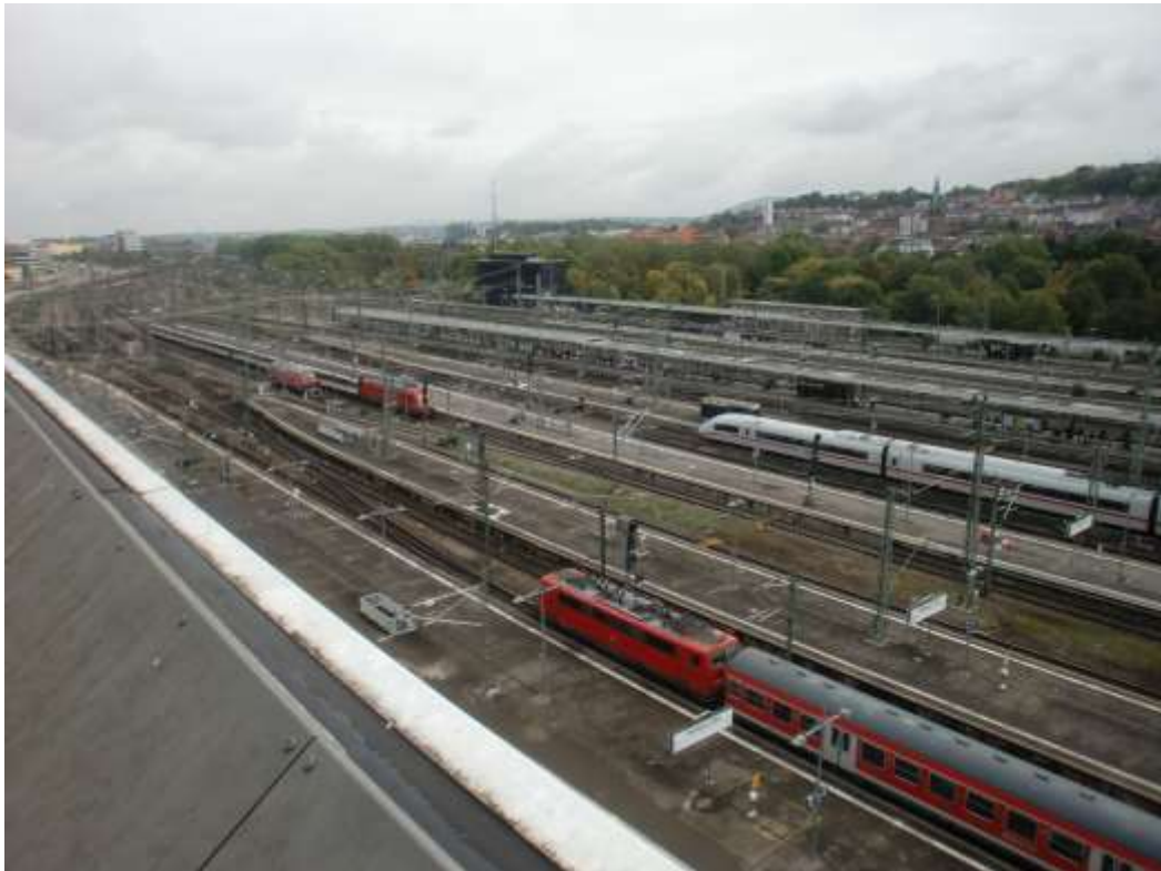
Abbildung 2: Blick auf das Baufeld bei Messende am 09.10.2017
