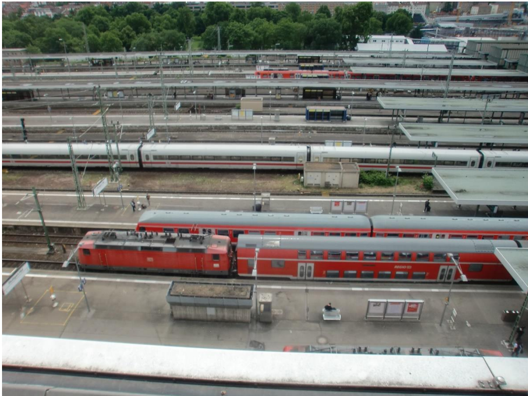
Abbildung 2: Blick auf das Baufeld bei Messende am 10.07.2017
