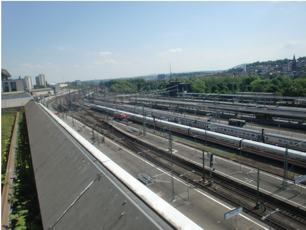
Abbildung 2: Blick auf das Baufeld bei Messende am 22.05.2017
