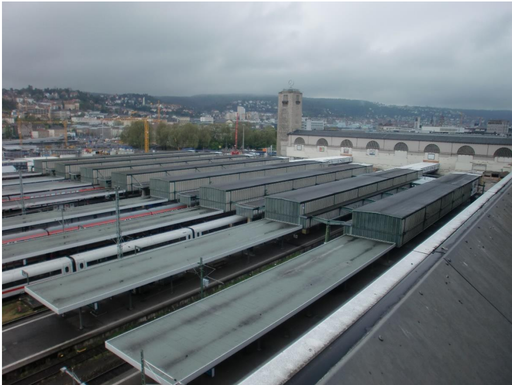
Abbildung 2: Blick auf das Baufeld bei Messende am 24.04.2017
