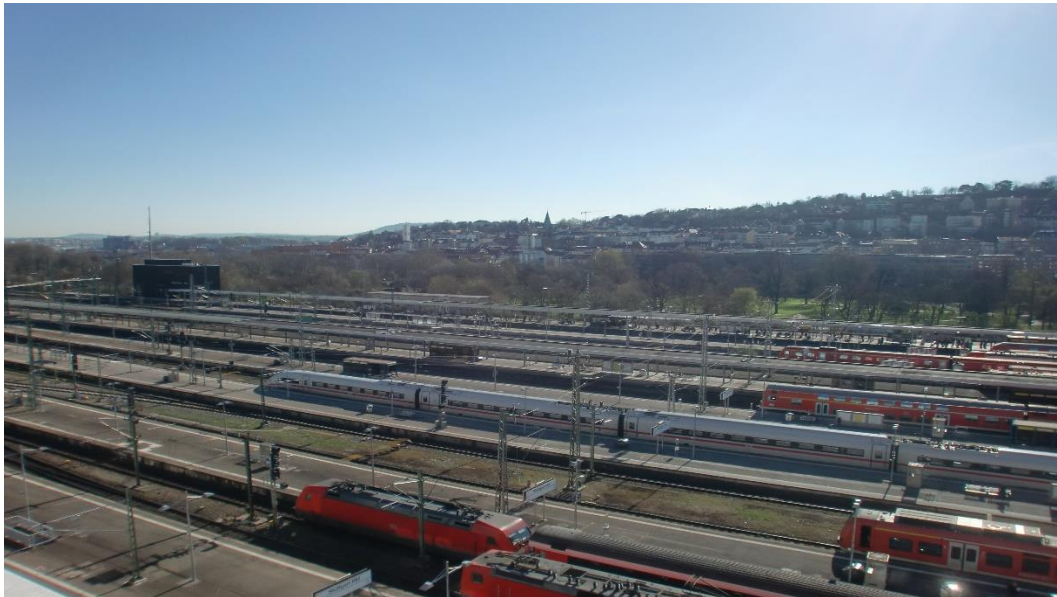
Abbildung 2: Blick auf das Baufeld bei Messende am 27.03.2017
