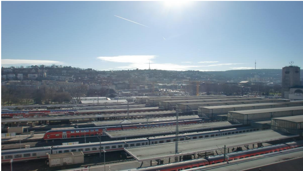
Abbildung 2: Blick auf das Baufeld bei Messende am 27.02.2017
