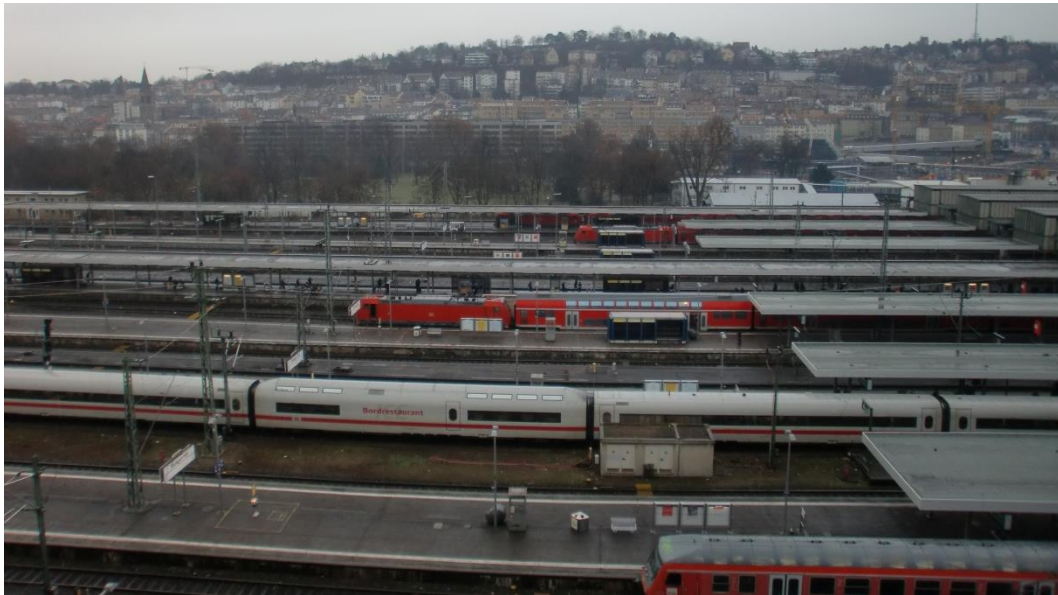
Abbildung 2: Blick auf das Baufeld bei Messende am 30.01.2017
