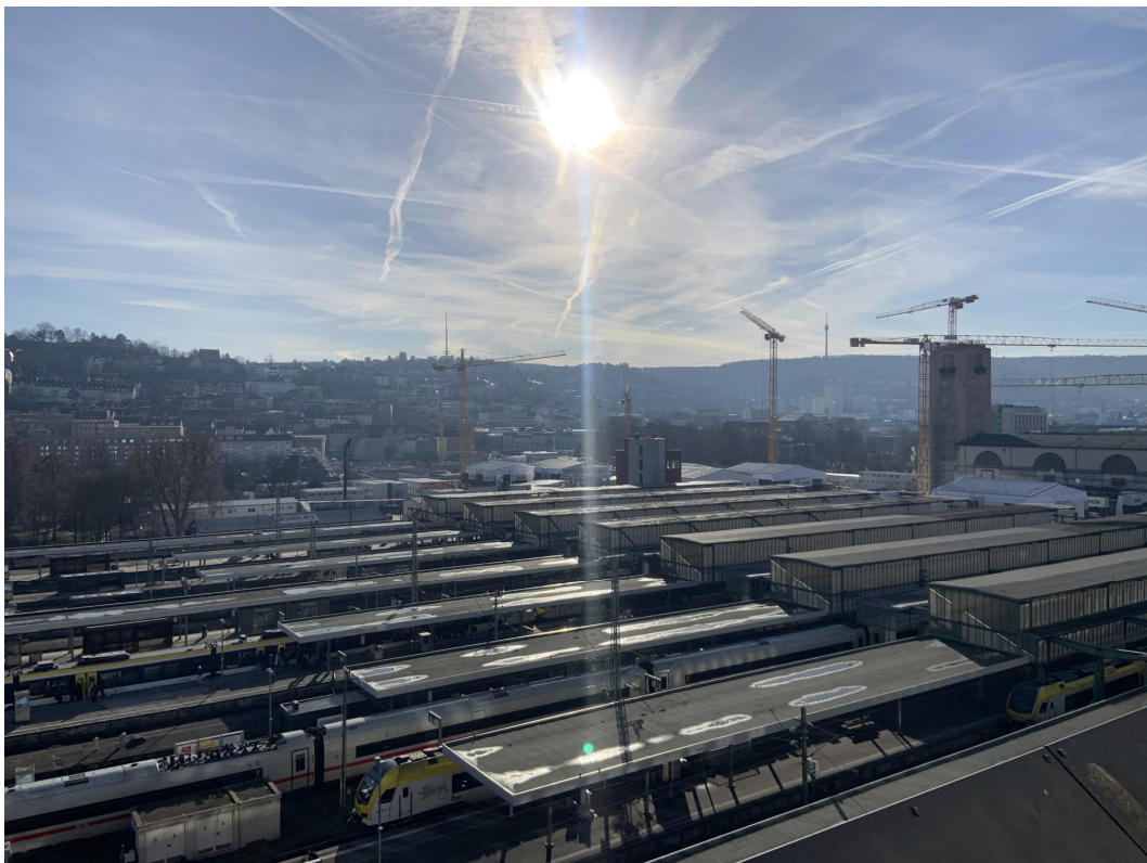
Abbildung 1: Blick auf das Baufeld bei Messbeginn am 18.03.2024
